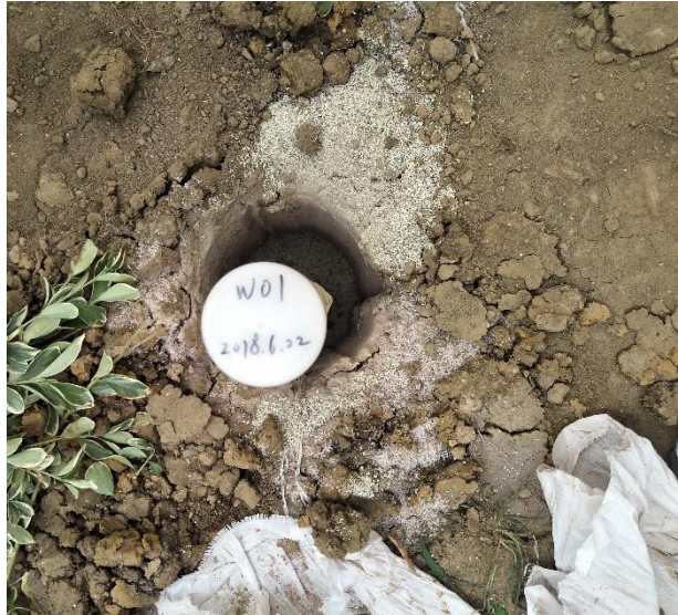
图 4.1-1 钻孔膨润土回填
